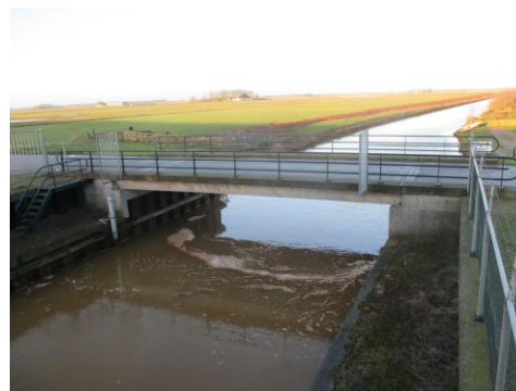
Betonnen brug OS03
