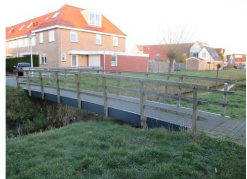
Voorbeeld type stalen brug: Brug OS02
