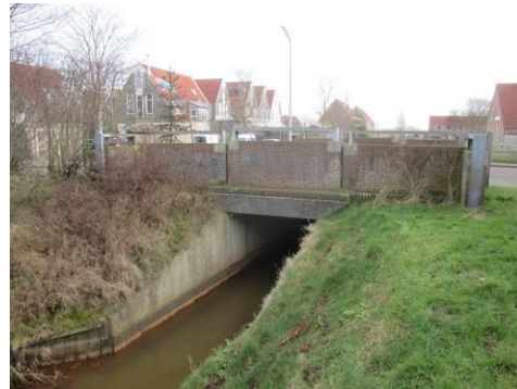
Voorbeeld betonnen duiker: Duiker DB01
