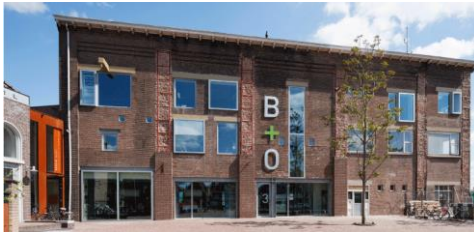
Gasfabriek Meppel – creatieve industrie
