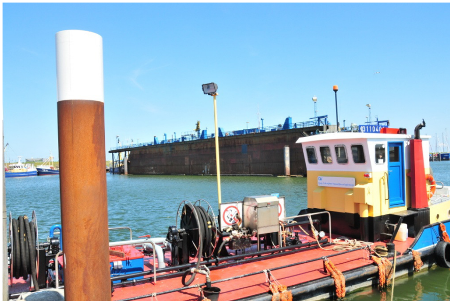
De werkhaven wordt multifunctioneel gebruikt.
