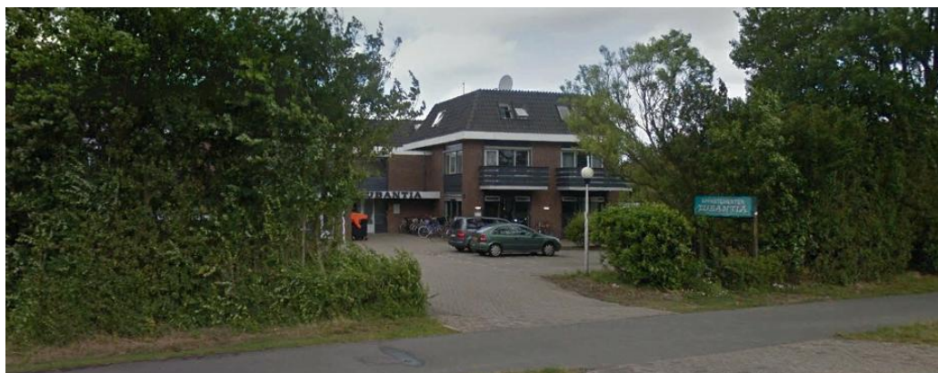
afb. 10 De planlocatie met appartementengebouw gezien vanaf de Pontweg
