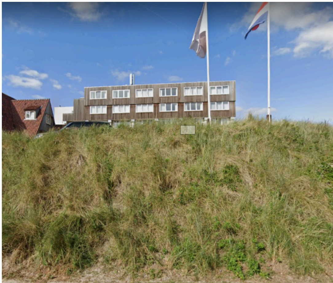
Afbeelding 1 Voorbeeld van een antenne installatie op een dak in De Koog. In dit specifieke geval een voorbeeld van T-Mobile.
